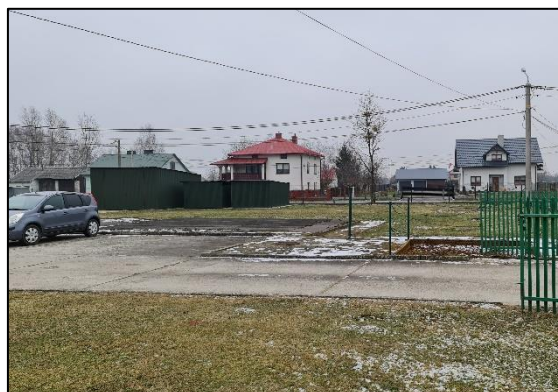
Rys. 12 - Widok terenu Stacji Uzdatniania Wody
