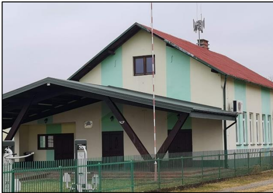
Rys. 21 – Widok elewacji południowej
