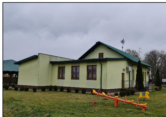
Rys. 37 – Widok elewacji południowej
