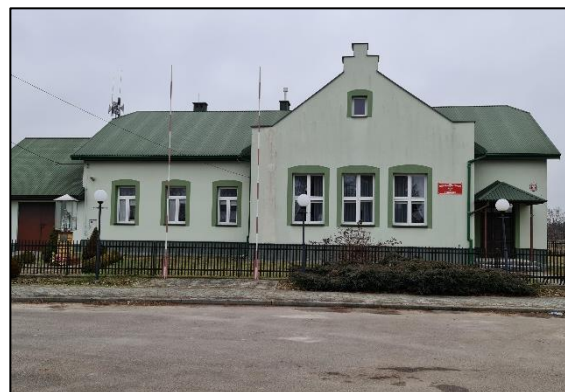
Rys. 33 – Widok elewacji południowej
