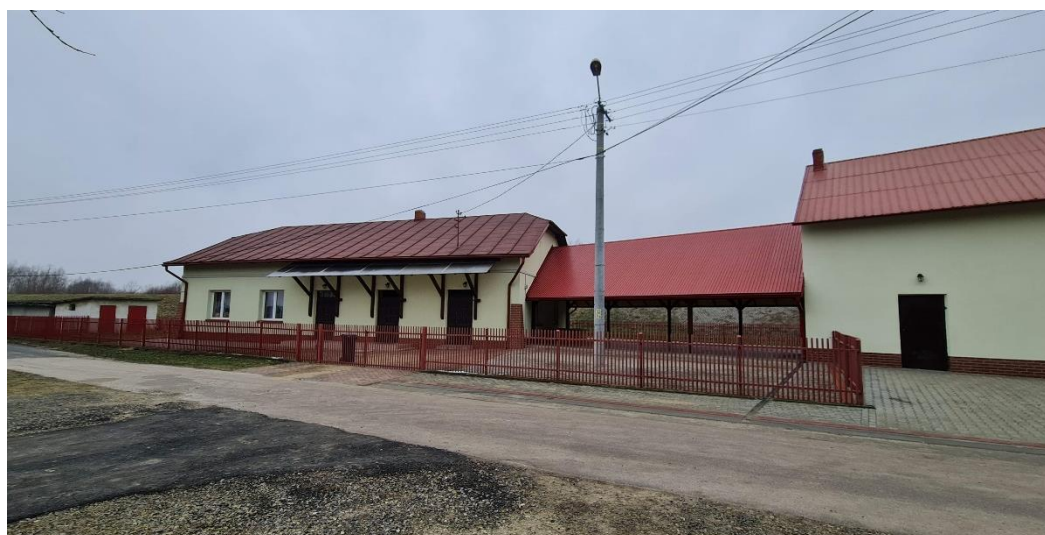
Rys. 13 - Widok elewacji południowej
