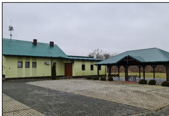
Rys. 36 – Widok elewacji północnej
