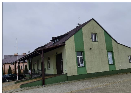
Rys. 17 – Widok elewacji północnej
