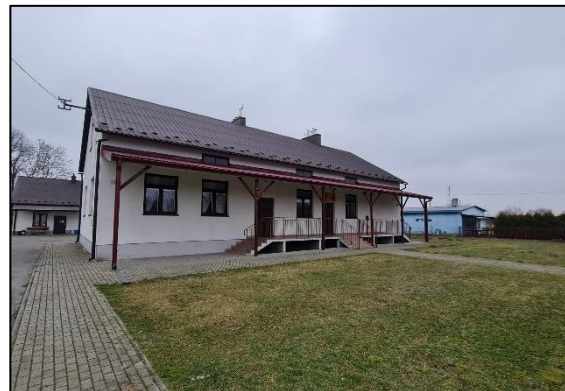
Rys. 29 – Widok elewacji południowej
