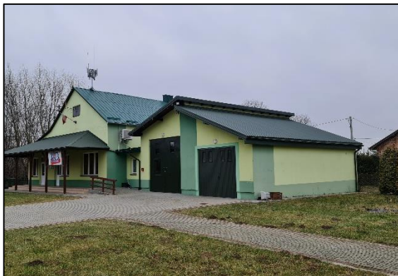
Rys. 24 – Widok elewacji północnej
