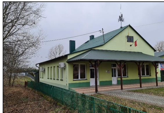
Rys. 25 – Widok elewacji południowej
