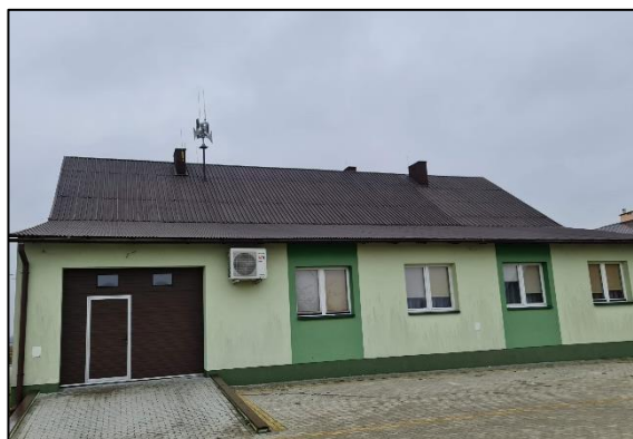
Rys. 16 – Widok elewacji południowo-zachodniej
