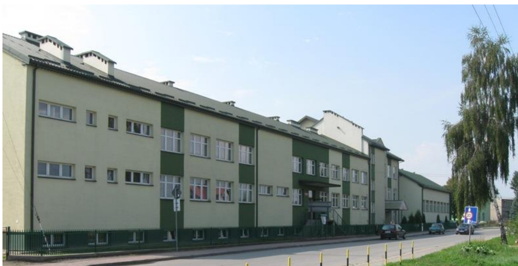
Rys. 10 - Widok elewacji północnej
