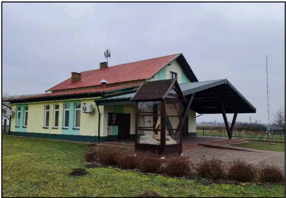
Rys. 20 – Widok elewacji północnej
