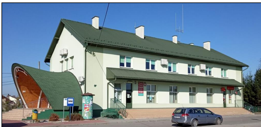
Rys. 7 - Widok elewacji zachodniej
