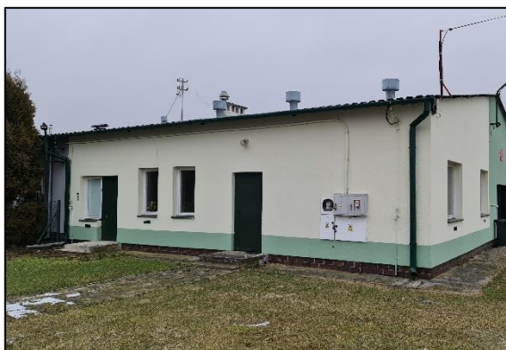
Rys. 11 - Budynek Stacji Uzdatniania Wody
